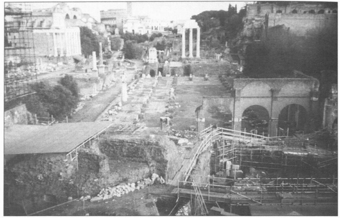
48 Gleichzeitig mit der Einrüstung begannen im gleichen Bereich neue Grabungen nach stratigraphischen Methoden; die Aufbereitung der Grabungsplätze (hier Via Sacra unterhalb des Kapitols) läßt auf sich warten; Abzäunungen, Schutzdächer und Abstützungen werden zu einem Dauerzustand
